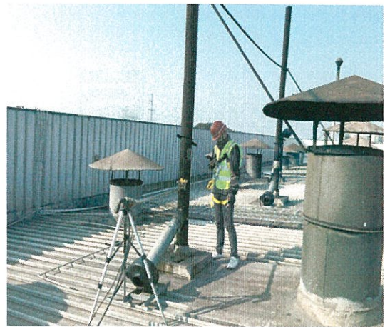
西区台架装配 2#线（◎2）
