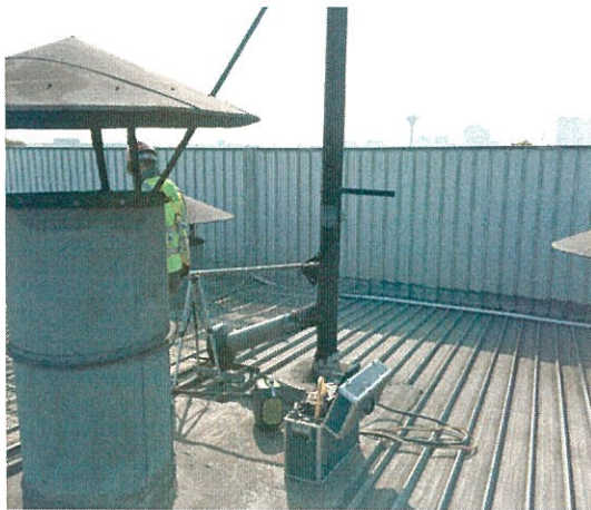
西区台架装配 3#线（◎3）
